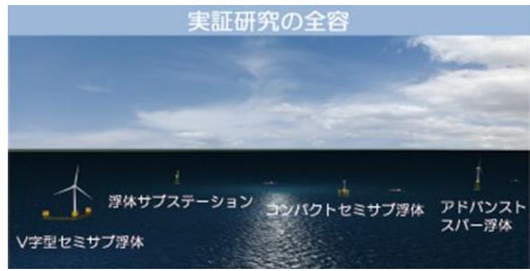
2MW+5MW+7MW+浮体式変電所
